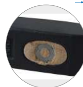
Fixação por cunha de metal
